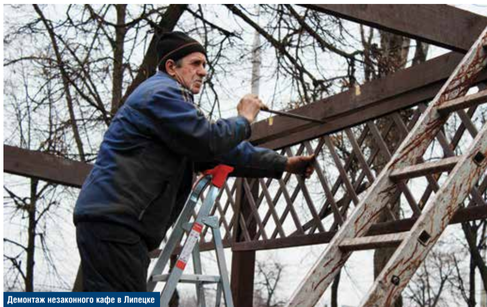
Демонтаж незаконного кафе в Липецке
