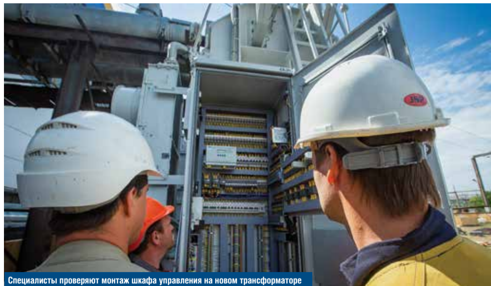
Специалисты проверяют монтаж шкафа управления на новом трансформаторе
