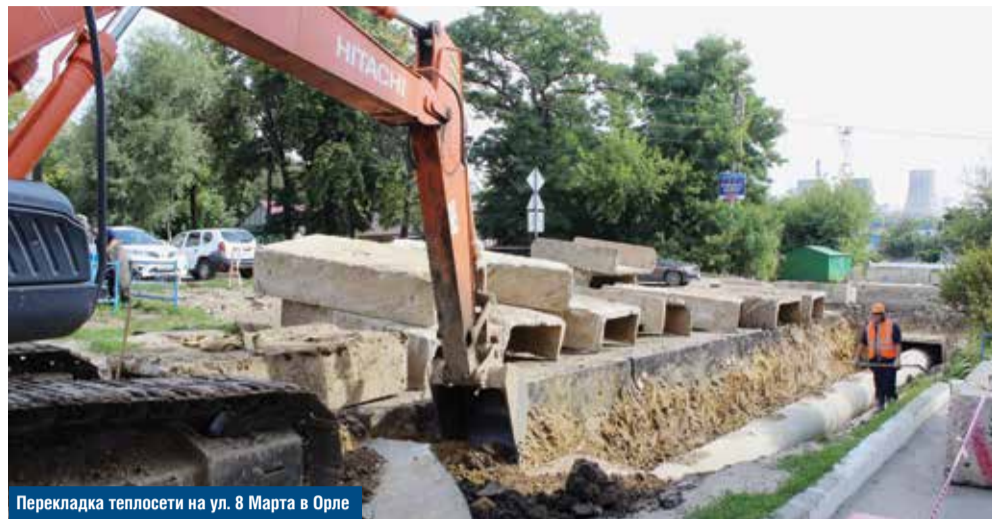
Перекладка теплосети на ул. 8 Марта в Орле
