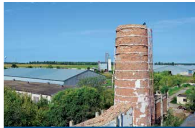
Вместо аварийной трубы котельной на ул. Глинки в Воронеже возведут две металлических
